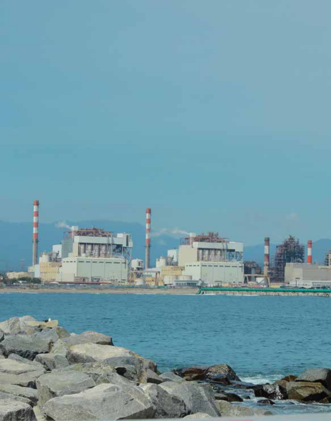
Fotografía: Marcela Melej / Termoeléctricas Aes Gener, Las Ventanas.
